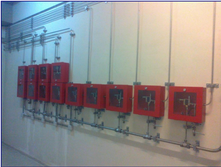
Instalación válvulas de control
