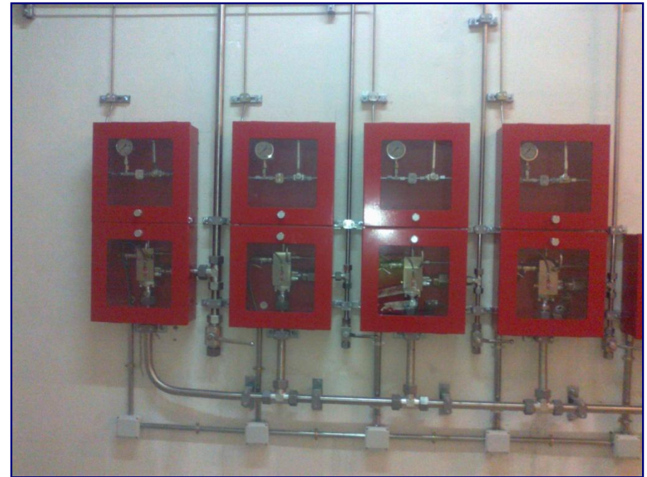
Instalación válvulas de control
